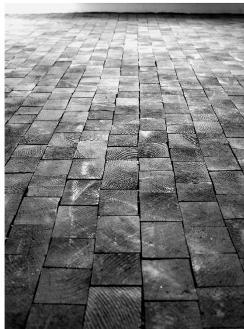
Sol en plots de bois, association bâtiment 71, ancien site des SIG, Plainpalais. Photographie: Marieke Palocsay
