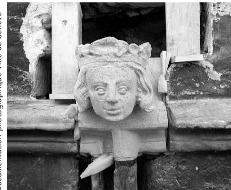
Mise en place d'une copie en mortier de ciment
