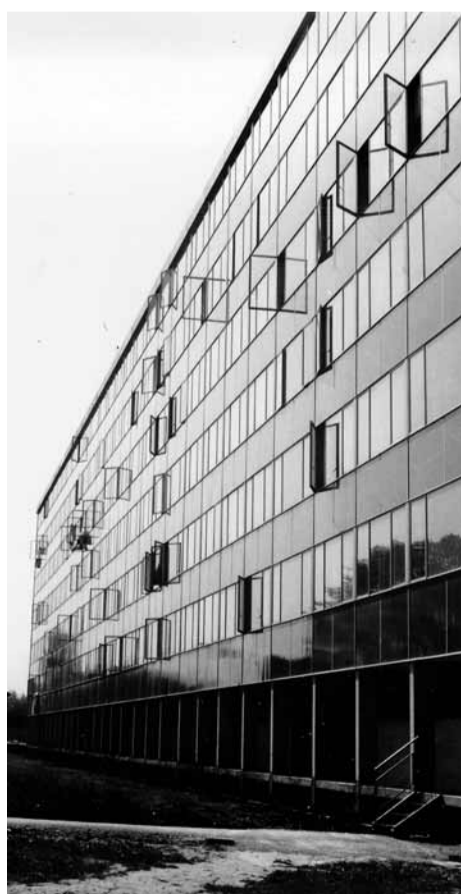
Immeuble « Les Ailes » à Meyrin, 1956-59, J.-P. Dom, J. Duret, F. Maurice architectes
