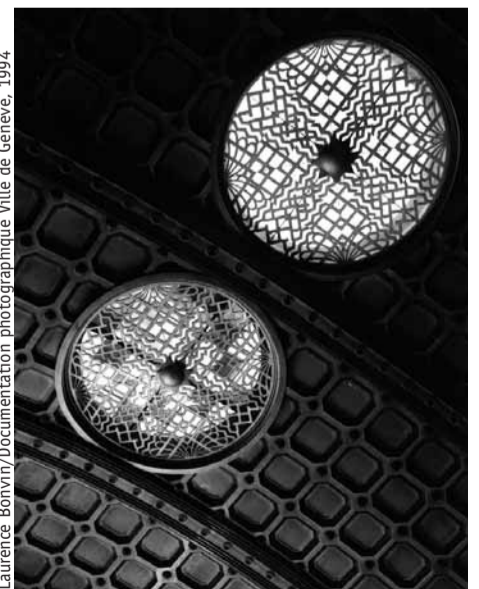
Plafond et deux puits de lumière
