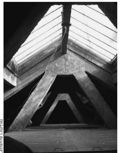
Combles avec verrière et caisson en bois, état en octobre 2007
