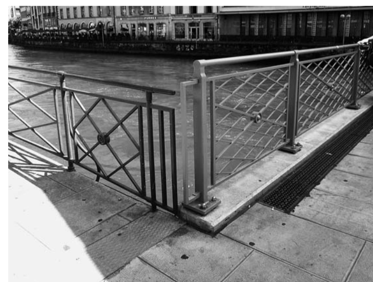
Pont de l'Île : après transformation du pont, exemple satisfaisant d'une réinterprétation des anciennes barrières pour répondre aux nouvelles sollicitations et normes de sécurité.
