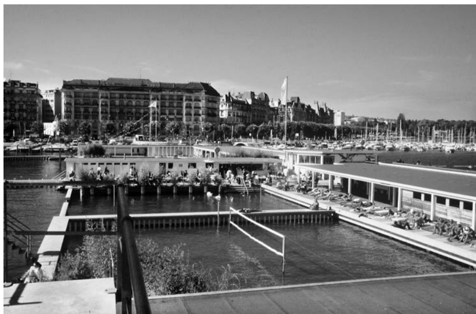
Les Bains des Pâquis. Construits en 1931-1932 en préfabriqué de béton, dans un style moderne minimaliste, par le service des travaux de la Ville de Genève (arch. Henry Roche, ing. Louis Archinard, entreprise Zschokke). Promis à une démolition-reconstruction, sous le prétexte d'une maladie du béton, ils furent sauvés en 1988 par un référendum de l'Association d'usagers des Bains des Pâquis (AUBP). Restauré en 1991-1995 grâce à un partenariat conclu entre l'AUBP, la Ville de Genève et les mandataires (Collectif d'architectes bbcm Marcellin Barthassat, Claude Butty, Gabriele Curonici et Jacques Menoud, ainsi que Jean-Pierre Cêtre, ingénieur), ce haut-lieu de délasserment est aujourd'hui géré par l'AUBP.
