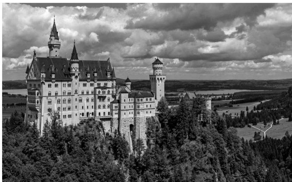
Neuschwanstein, construit entre 1869 et 1884 pour Louis II de Bavière sur les ruines de deux châteaux-forts médiévaux. Le roi avait visité Pierrefonds en 1867. Pour obtenir le palais de ses rêves, il fit dynamiter la montagne.
