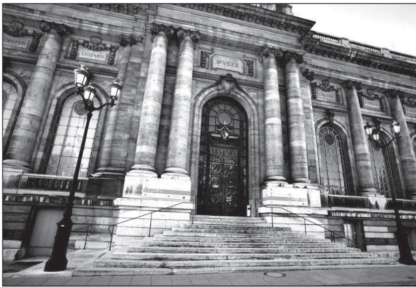
Le Conseil administratif devra prendre en compte les critiques de la puissante Commission des monuments, de la nature et des sites. JPDS
