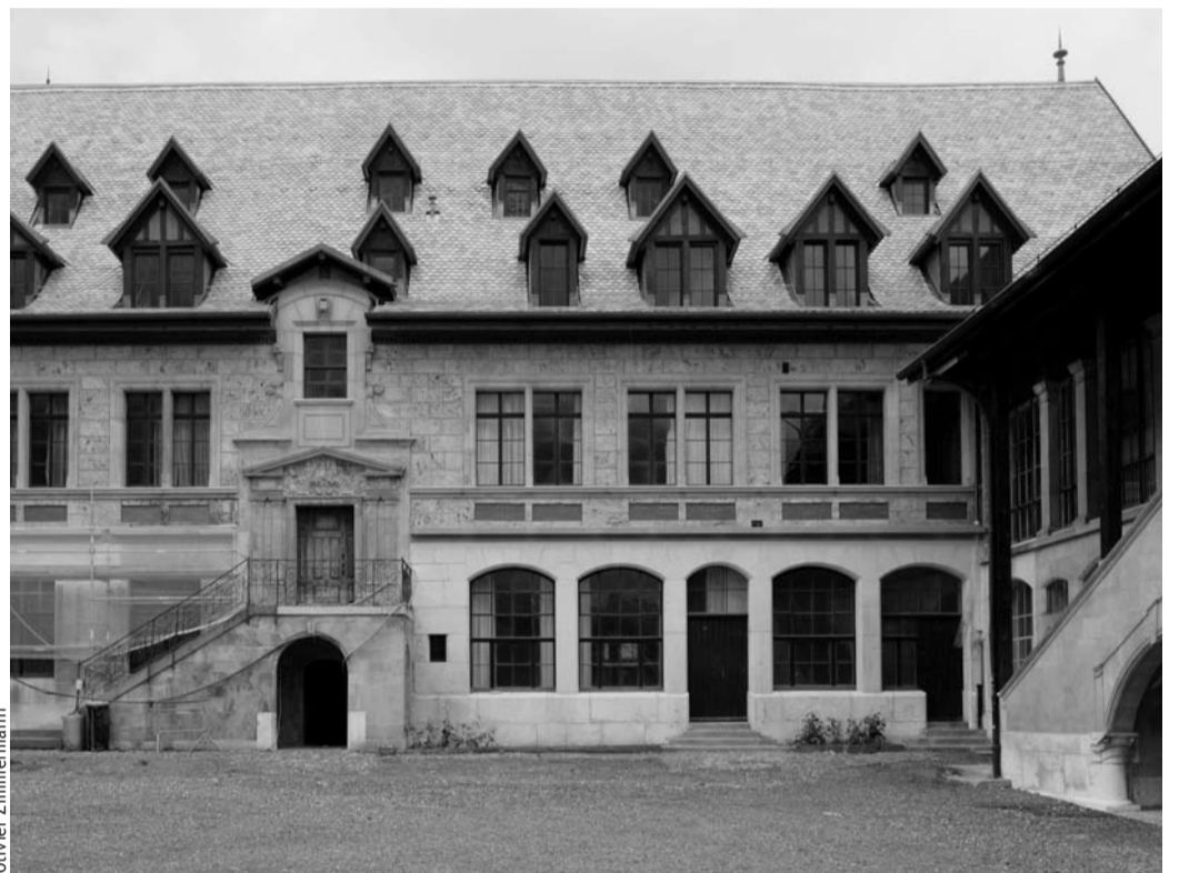
Le bâtiment A (aile sud) en 2010, après la fin des travaux de restauration de l'enveloppe extérieure. On peut remarquer la teinte claire des tuiles et la remise en état des lucarnes du XVI e siècle.
