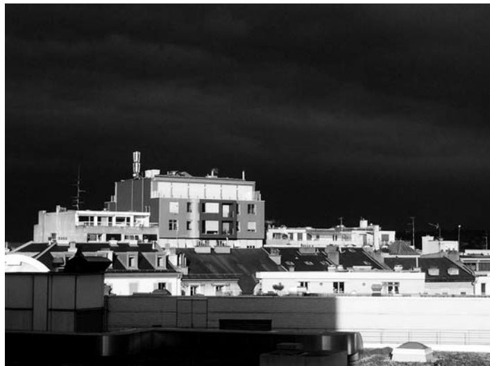
Surélévation isolée de l'immeuble rue de la Servette 21 (2015-2016).
