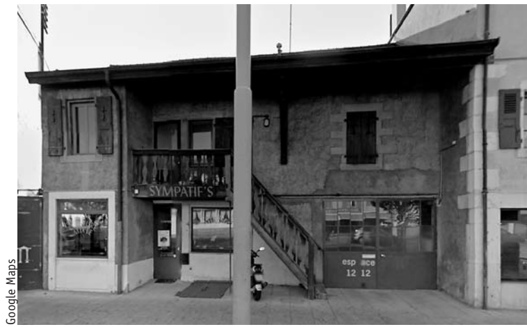
Route du Grand-Lancy 53, avant démolition.
