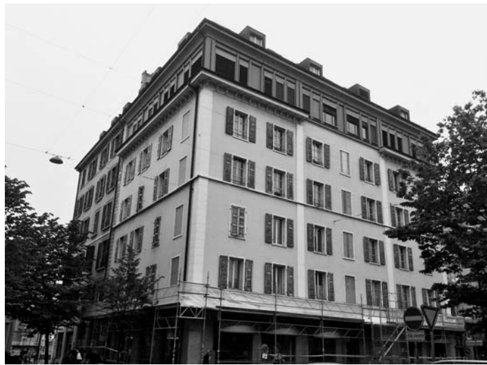
Surélévation première génération (1986) de l'immeuble XIX e rue Argand 2, harmonisation à la notion d'ensemble.
