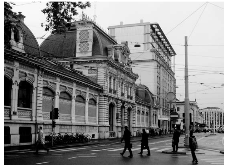
Rehaussement de 3 étages de l'hôtel Cornavin (1996-1998), en dérogation de la loi LCI, avant loi de surélévation de 2008.
