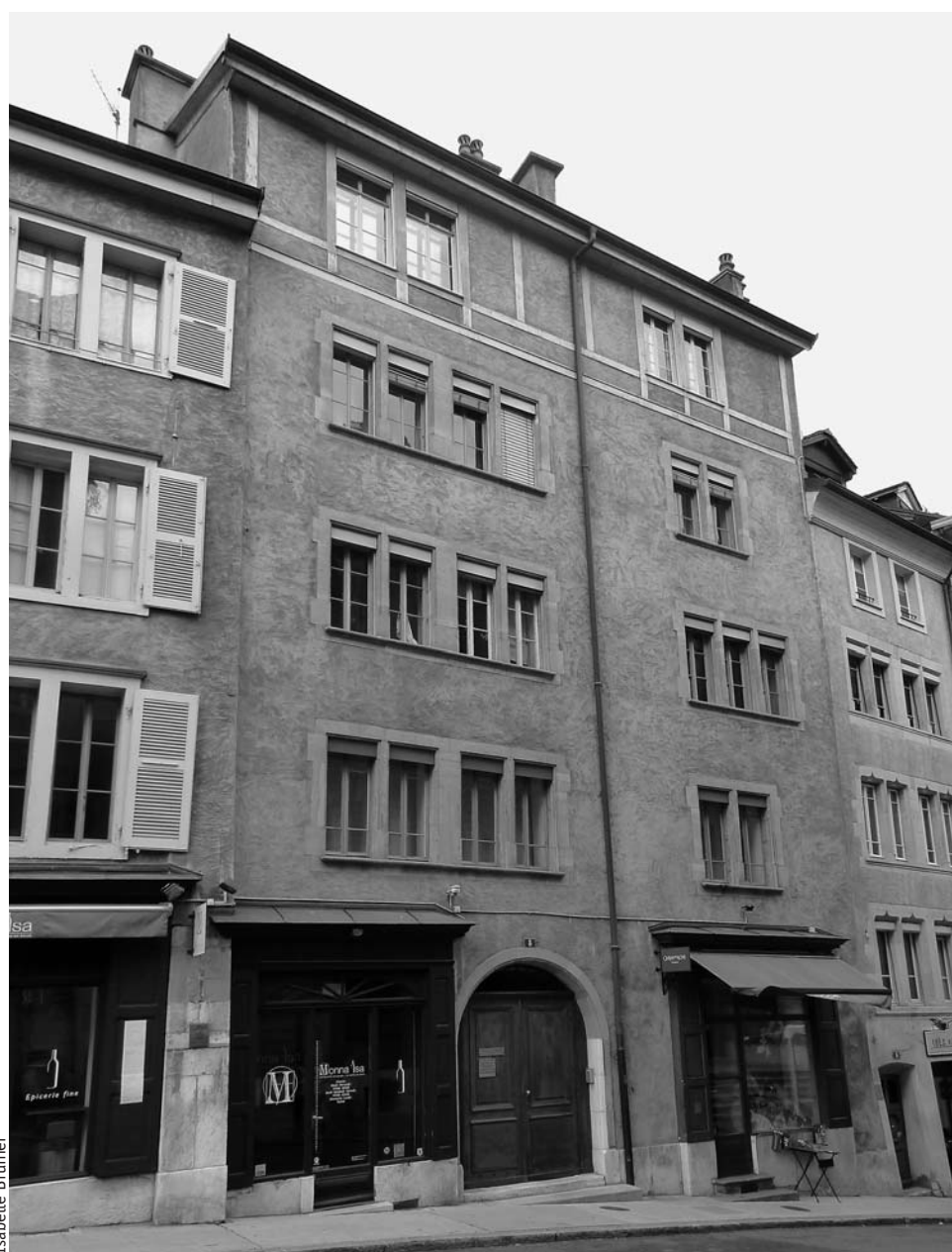
Surélévation fin du XVIII e siècle, place du Bourg-de-Four 8.
